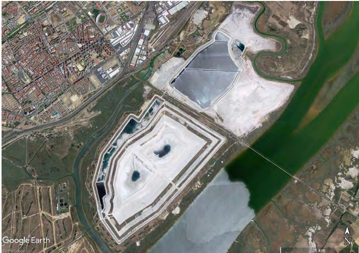
Imagen 1. Balsas de fosfoyesos junto a la ciudad de Huelva. Los fosfoyesos son residuos de la producción industrial de fertilizantes fosfatados, cuyo almacenamiento resulta problemático por su toxicidad y radiactividad. En el caso de Huelva, su peligrosidad se ve acentuada por la subida del nivel del mar debido al cambio climático. Su dimensión puede apreciarse por la comparación con el estadio deportivo arriba a la izquierda
