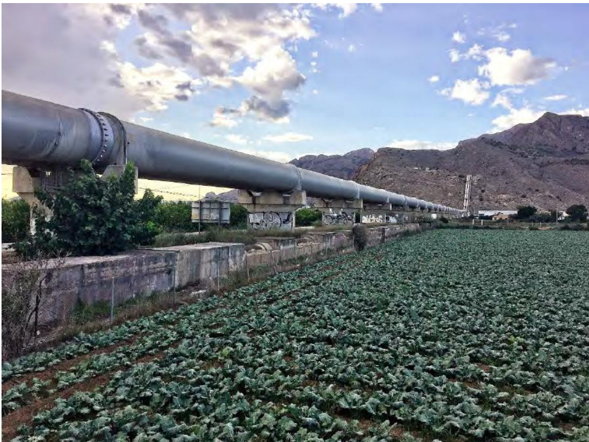
Imagen 2. La infraestructura de riego requiere grandes cantidades de energía para su construcción, mantenimiento y operación. En la imagen, tuberías del trasvase Tajo-Segura en Alicante.
